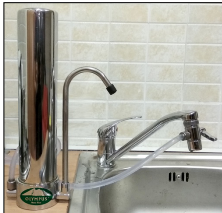
Filtr podłączony do baterii zlewozmywaka
