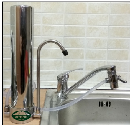
Filtr podłączony do baterii zlewozmywaka
