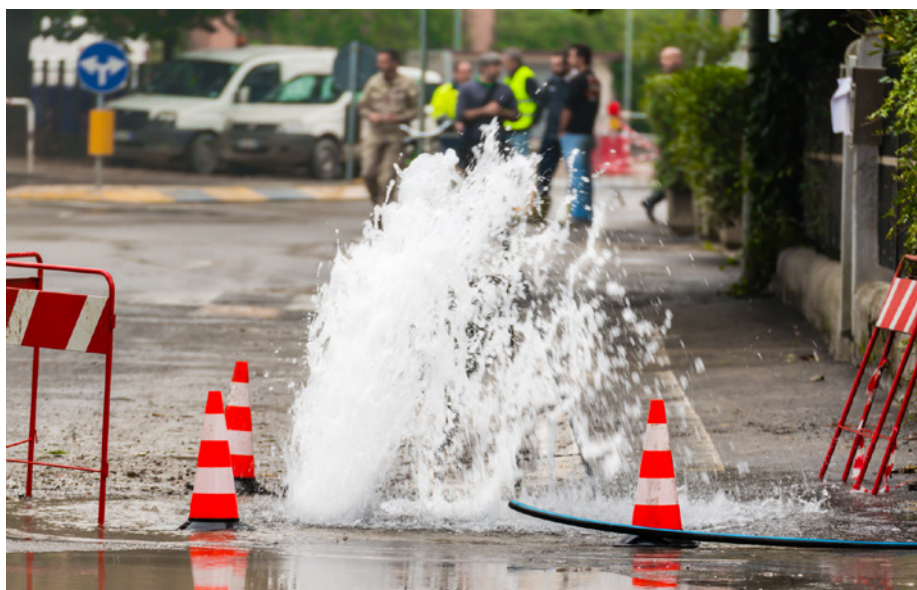
Zdjęcie nr 4 Awaria sieci wodociągowej
